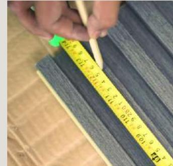
Meça e marque a altura e largura da área onde o painel ripado refilado, utilizando uma fita métrica e um lápis.
