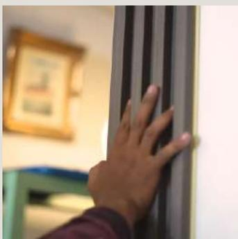
Após espalhar a cola, posicione as ripas no local desejado na parede e pressione-as firmemente contra a superfície.
