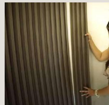
Comece pelo canto inferior da parede e coloque a primeira ripa do painel ripado no local desejado. Verifique se está nivelada e alinhada corretamente.
