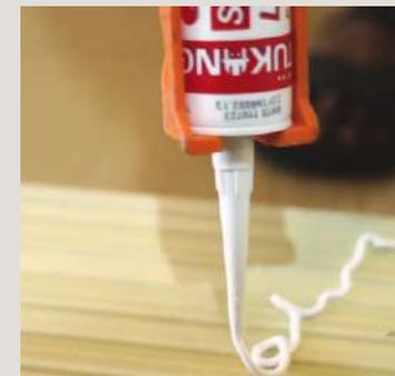
Antes de aplicar a cola PU no painel ripado de WPC, certifique-se de que a superfície das ripas esteja limpa. Aplique a cola em filetes ou pontos na parte traseira das ripas, garantindo uma cobertura uniforme. Evite aplicar uma camada muito grossa de cola para facilitar a instalação.
