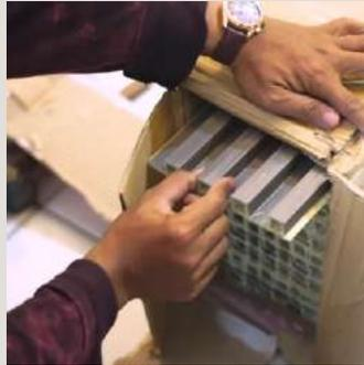
Caso o painel ripado possua textura que precise de encaixe, verifique se há uma orientação específica para a instalação correta das ripas.
