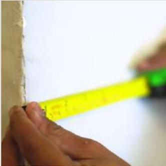
Verifique se a superfície da parede está limpa, Meça e marque a altura e largura da área. Certifique-se de nivelar corretamente as marcações.
